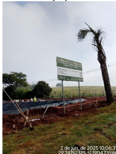
Figura 3: Local de ampliação do aterro sanitário
