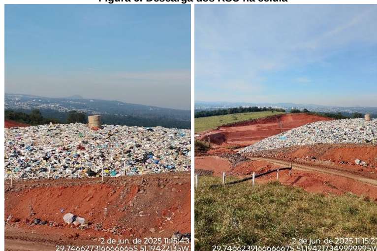
Figura 6: Descarga dos RSU na célula
