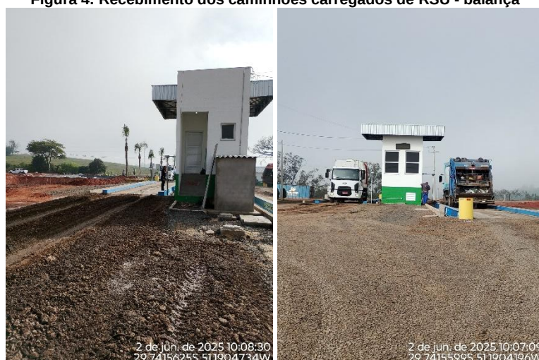
Figura 4: Recebimento dos caminhões carregados de RSU - balança
