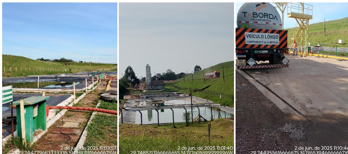
Figura 7: Lagoas de acúmulo de lixiviado e carregamento do caminhão
