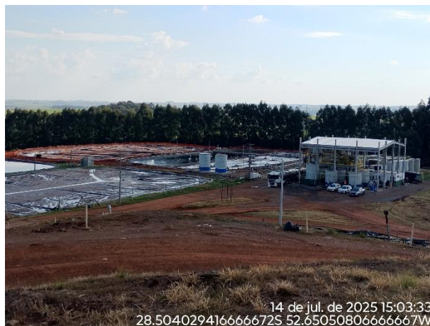
Figura 7: Estação de Tratamento de Efluentes
