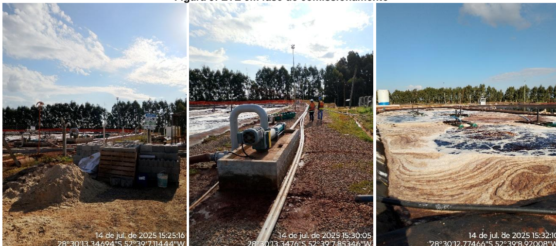
Figura 9: ETE em fase de comissionamento
