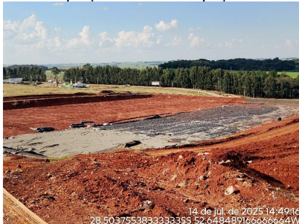
Figura 3: Área de operação atual e obra de ampliação do aterro sanitário
