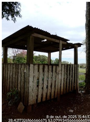
Figura 3: Local de acondicionamento de RSU na zona rural.
