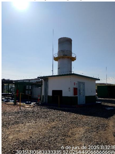
Figura 8: Sistema de captação de gás gerado e usina de biogás
