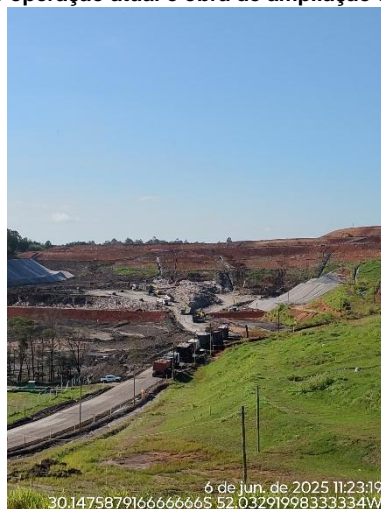
Figura 3: Área de operação atual e obra de ampliação do aterro sanitário
