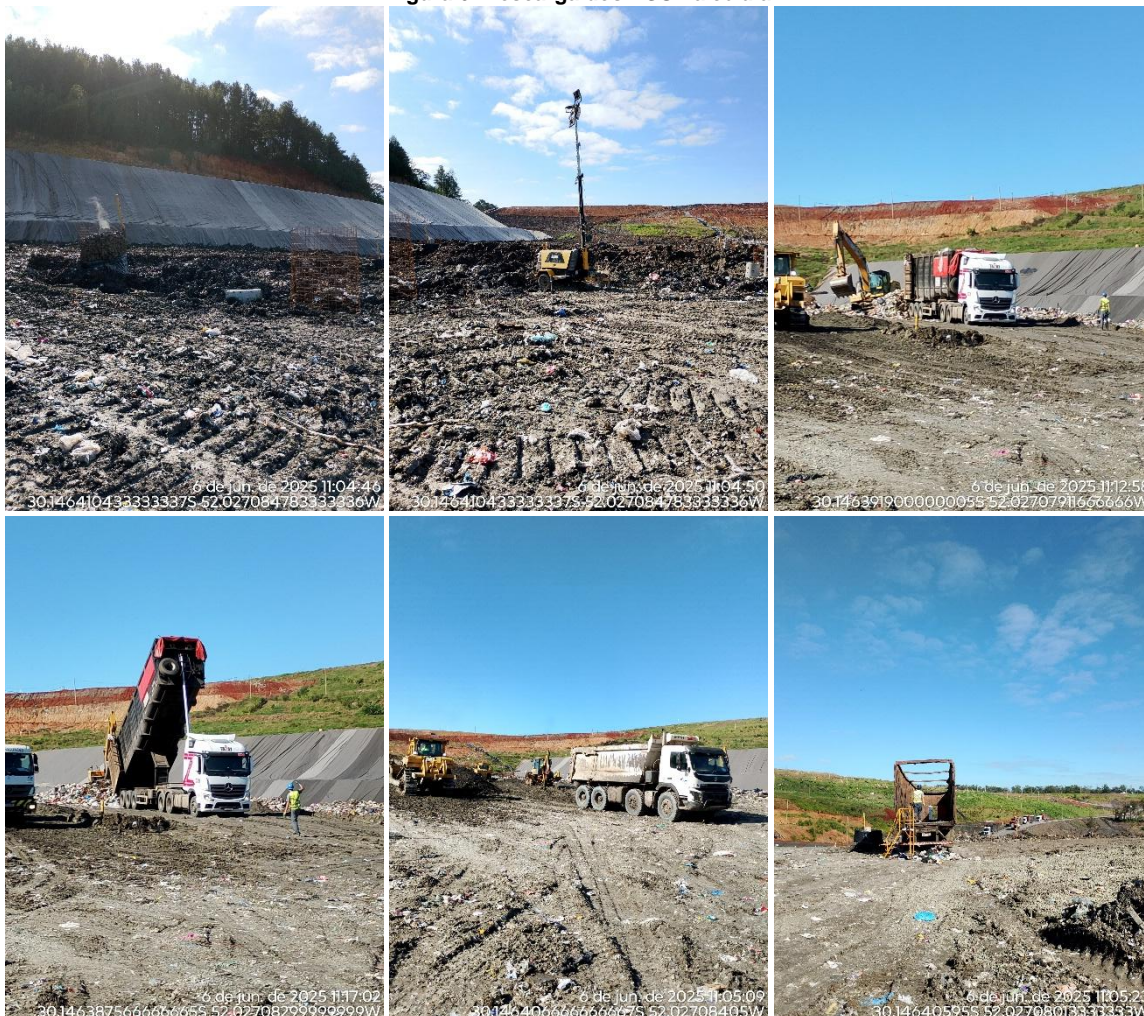
Figura 6: Descarga dos RSU na célula
