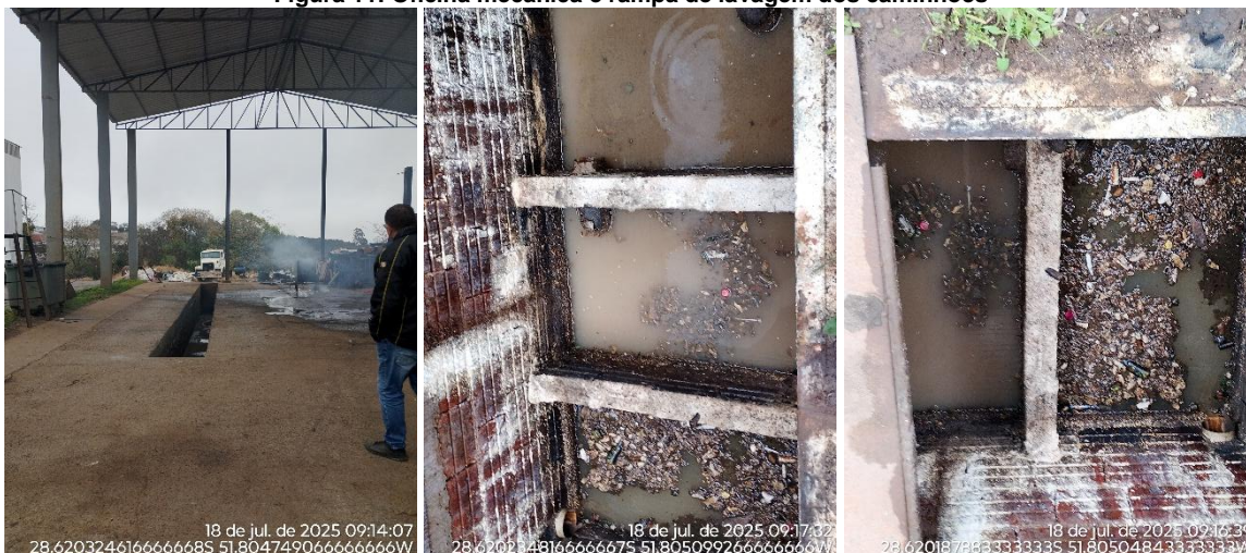
Figura 11: Oficina mecânica e rampa de lavagem dos caminhões
