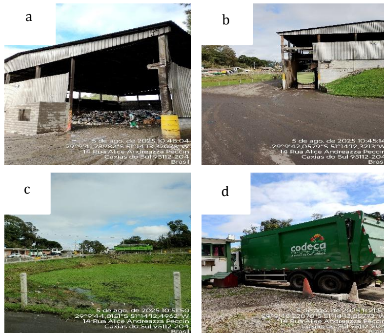
Figura 03: Unidade de transbordo de RSU de Caxias do Sul. a) Vista frontal da Unidade de Transbordo; b) Acompanhamento da transferência de resíduos para o caminhão de transporte; c) Transporte da unidade de Transbordo para a destinação final e d) Processo de pesagem de veículo de coleta a descarregar na Unidade de Transbordo.
