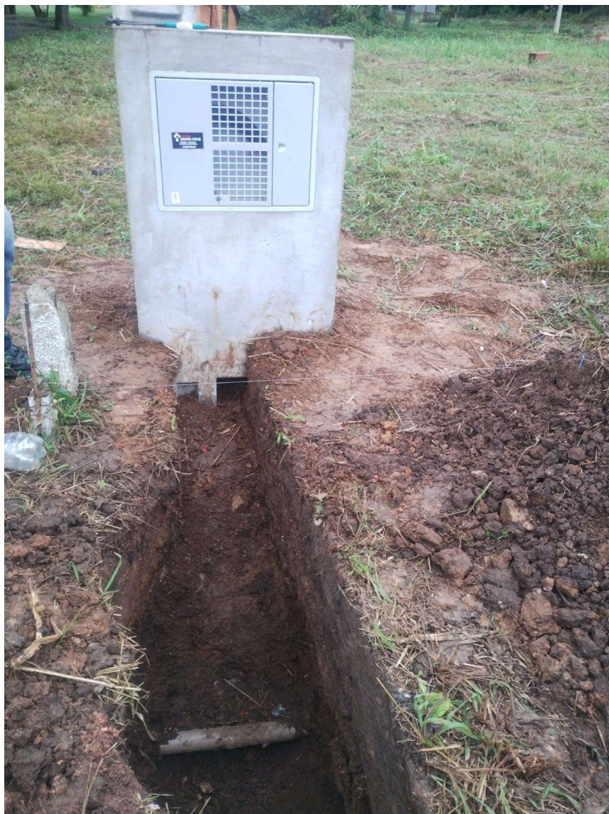
Figura 1 - Mureta e escavação preparadas para execução da ligação. O tubo de proteção/ponto de ligação deve permanecer visível e acessível à equipe.
