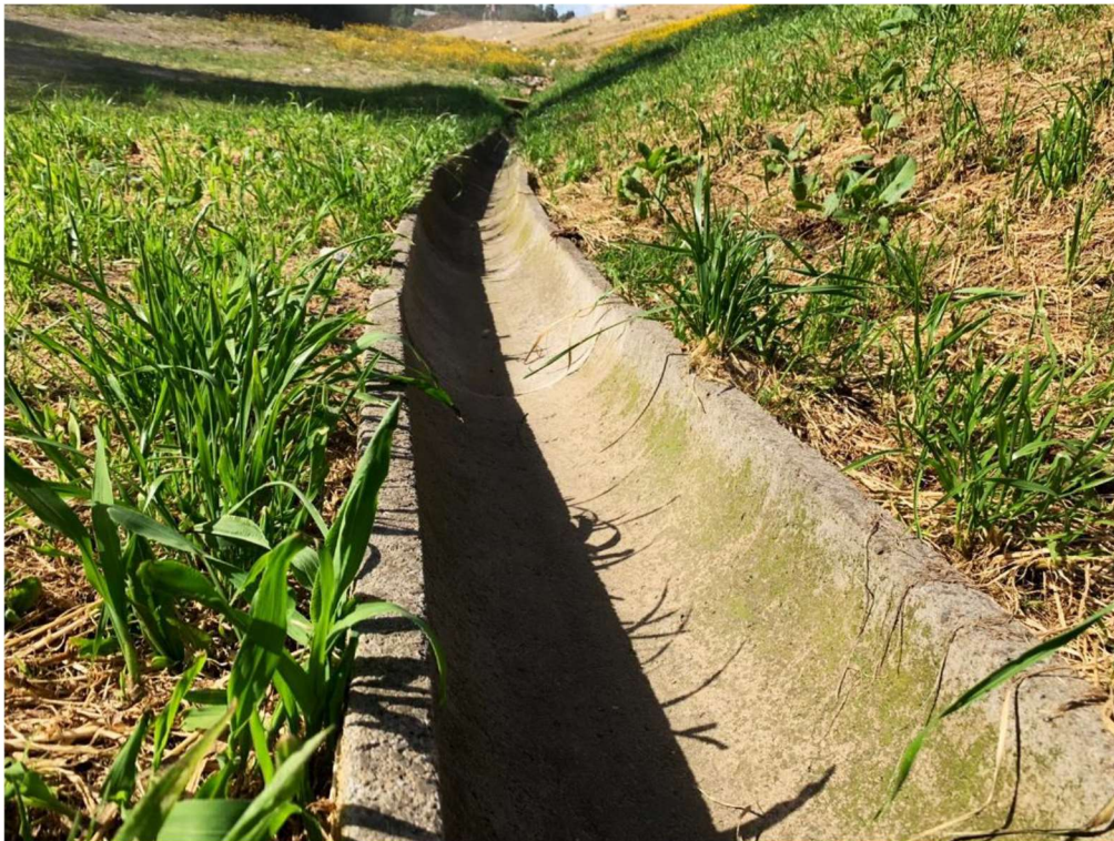
Figura 4: Canaletas de drenagem pluvial.
