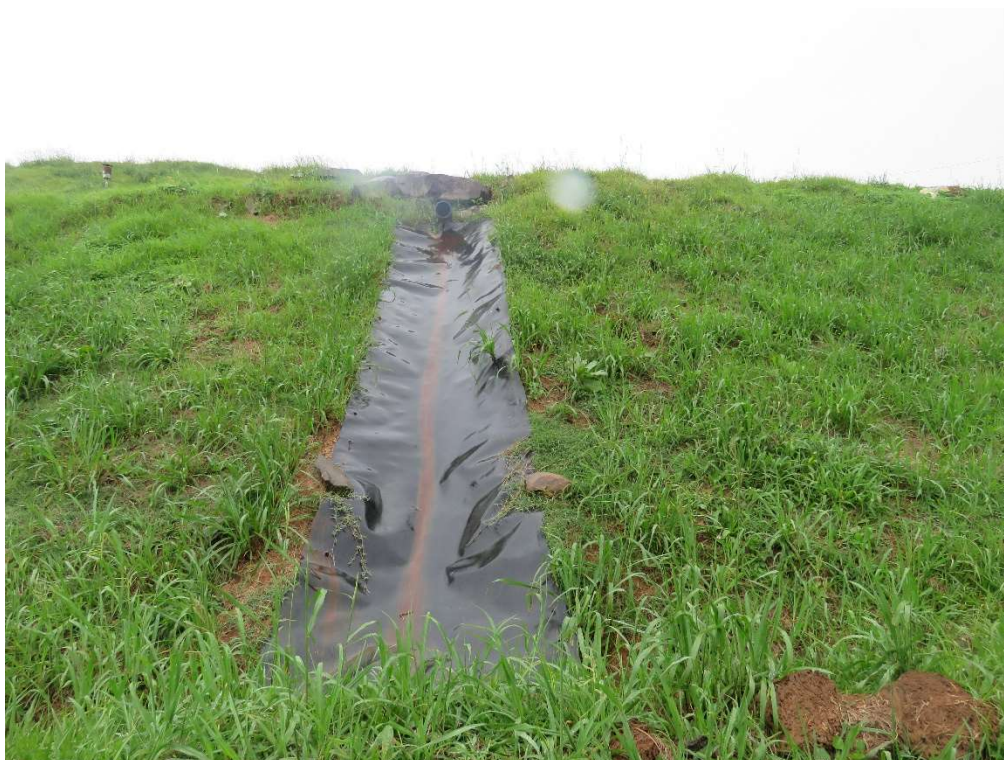
Figura 5: Calhas de drenagem pluvial.
