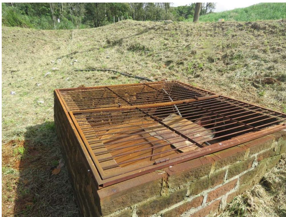
Figura 21: Área de armazenagem temporária de água.
