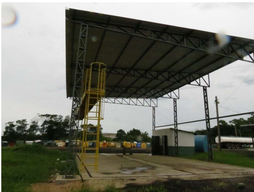
Figura 4948: Vista da nova área de lavagem.
