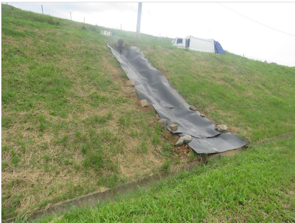
Figura 48: Calhas de drenagem pluvial revitalizadas.
