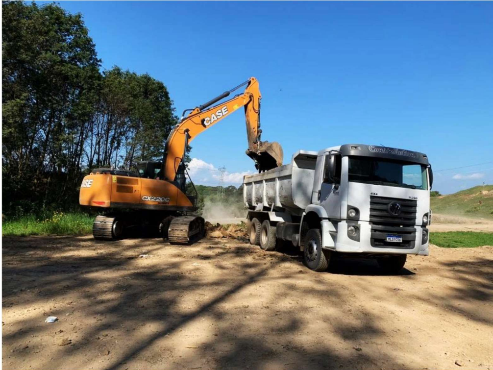
Figura 15: Escavadeira hidráulica e caminhão caçamba.
