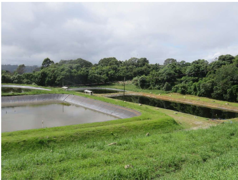
Figura 3: Lagoas de armazenamento de lixiviado.
