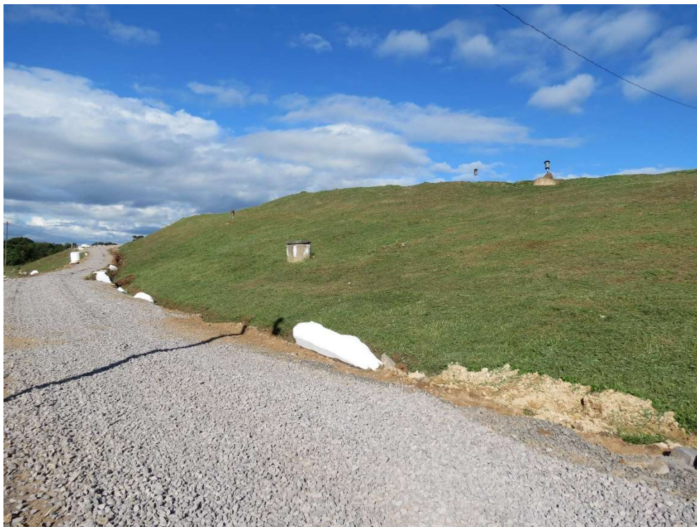
Figura 12: Demarcação das vias internas.
