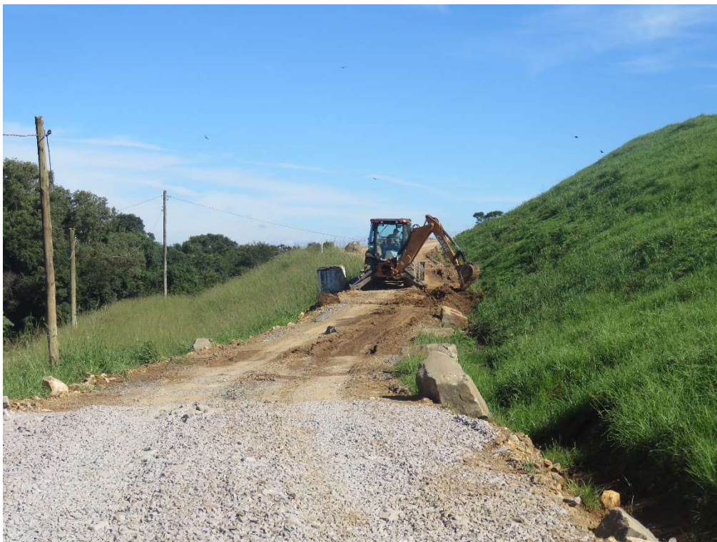
Figura 10: Acesso à área de descarga com a manutenção sendo realizada.
