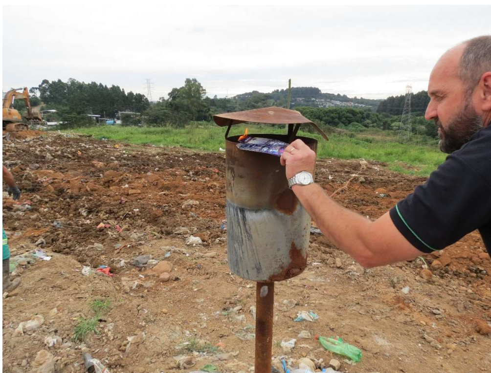
Figura 6: Drenos de gases.
