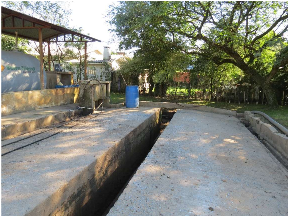
Figura 17: Área de abastecimento e rampa de lavagem.
