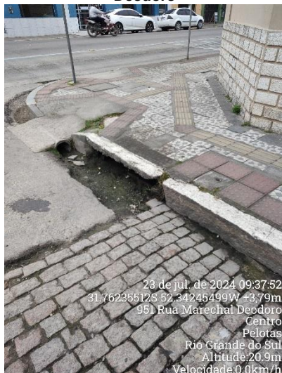
Figura 3 – Microdrenagem ponto 1 – Rua Marechal Deodoro
