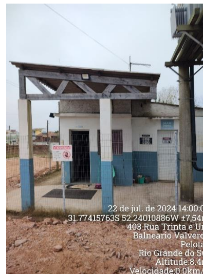
Estação de bombeamento - Pontal da Barra
