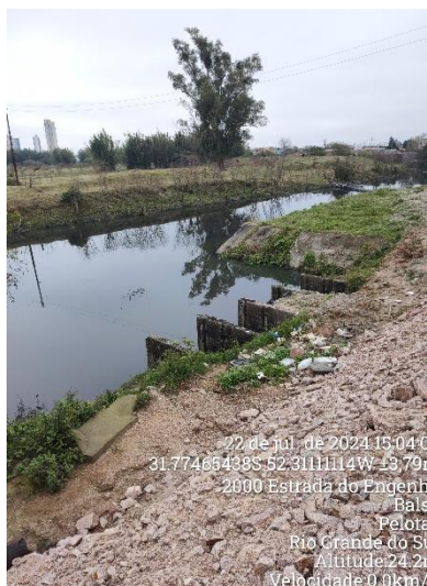
Canal da Casa de Bombas Leste
