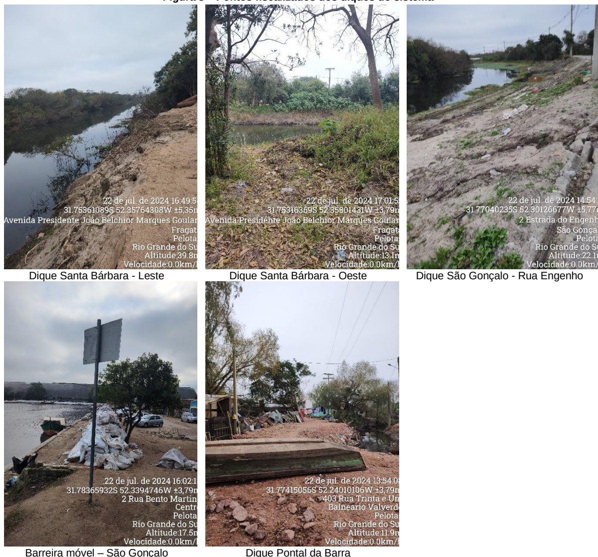
Figura 8 – Pontos fiscalizados dos diques do sistema
