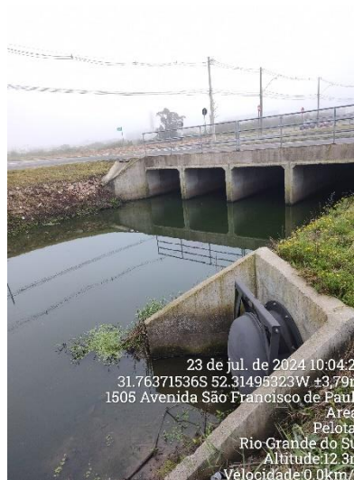
Canal da Casa de Bombas – Av. São Francisco de Paula
