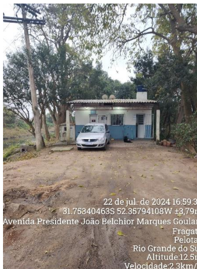
Estação de bombeamento – Farroupilha
