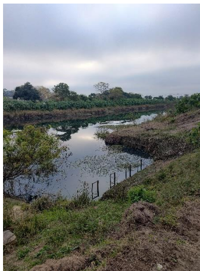
Canal Santa Bárbara Oeste
