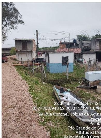
Estação de bombeamento - Simões Lopes
