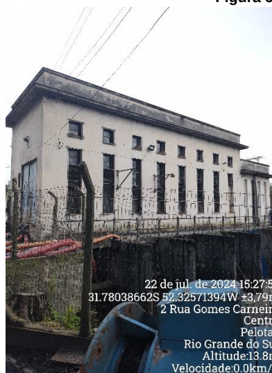
Estação de bombeamento – Anglo
