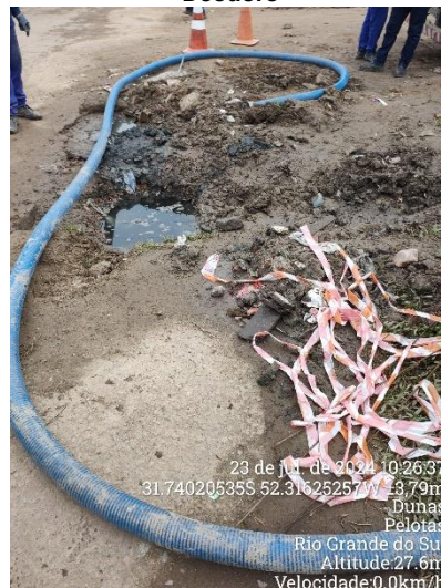
Figura 4 – Microdrenagem ponto 2 – Rua Marechal Deodoro
