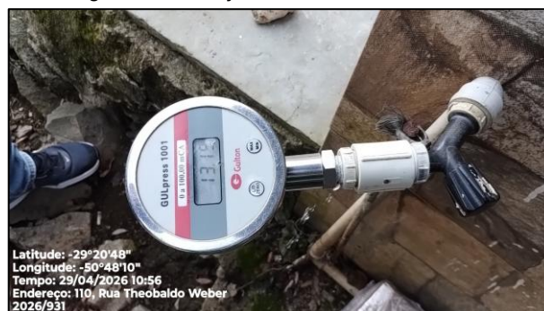
Figura 3 – Execução do teste com manômetro.
