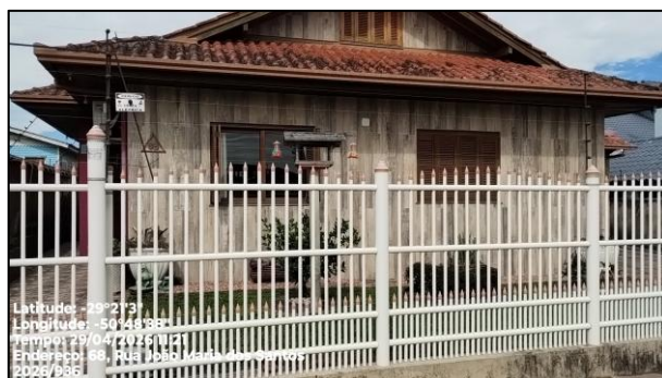
Figura 2 – Fachada da casa n.68.
