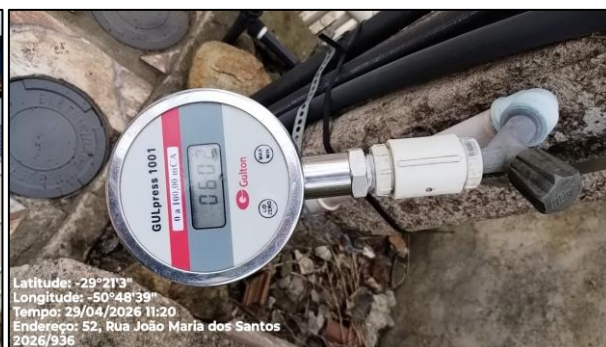
Figura 3 – Execução do teste com manômetro.
