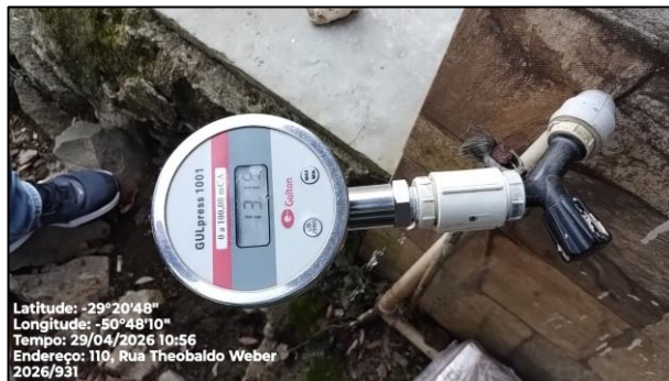
Figura 3 – Execução do teste com manômetro.
