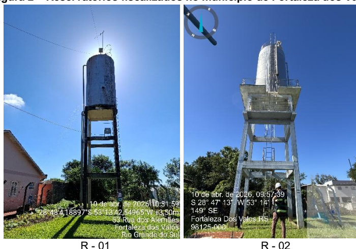
Figura 2 – Reservatórios fiscalizados no município de Fortaleza dos Valos.
