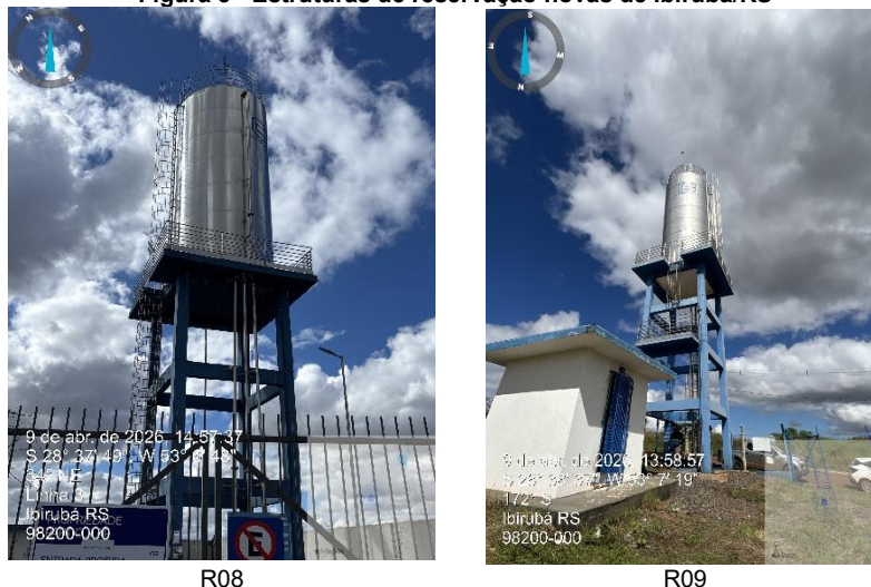
Figura 3 - Estruturas de reservação novas de Ibirubá/RS
