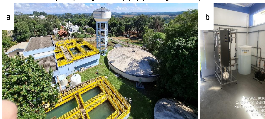
Figura 02: ETA de Veranópolis. a) visão geral da ETA; b) equipamento gerador de hipoclorito de sódio instalado.
