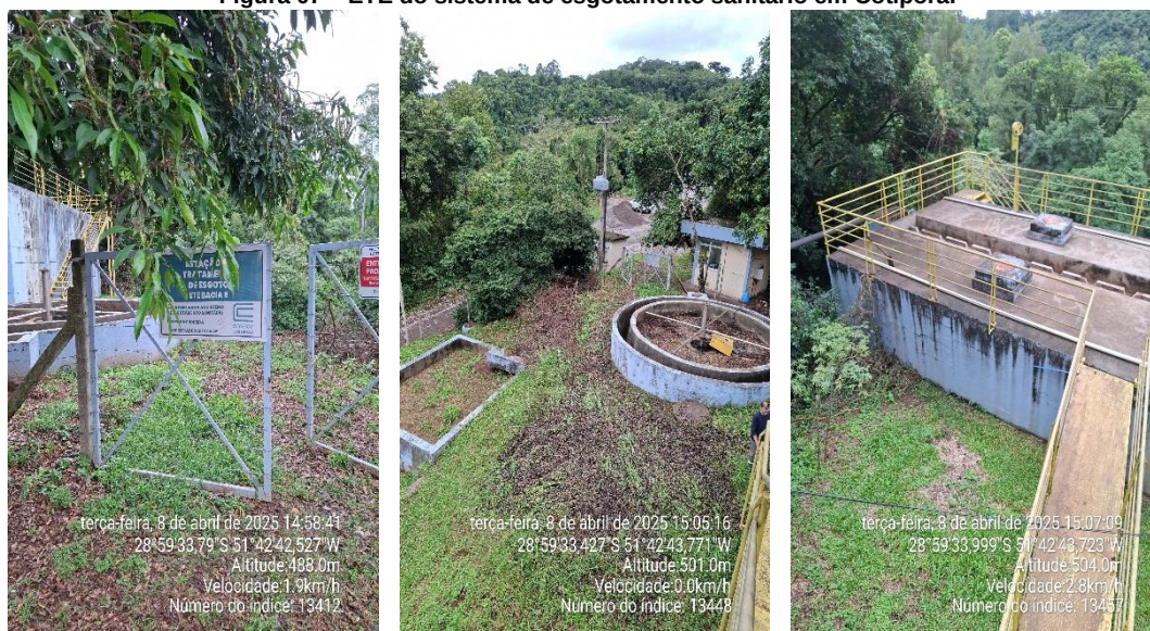
Figura 07 – ETE do sistema de esgotamento sanitário em Cotiporã.
