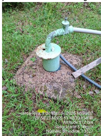
Figura 04: Poço COT-02 na área da Barragem do Arroio Leão.
