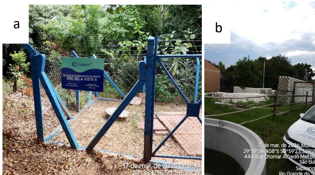
Figura 05: Identificação das modificações nos TSC. a) TSC Bela Vista II convertido em EBE e b) TSC Nellyta Meltzer em obras para conversão em EBE.
