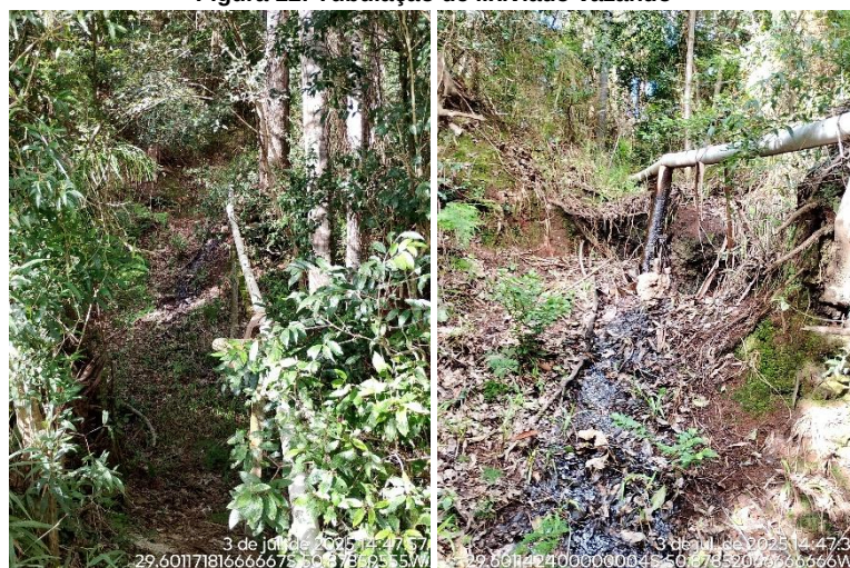
Figura 12: Tubulação de lixiviado vazando
