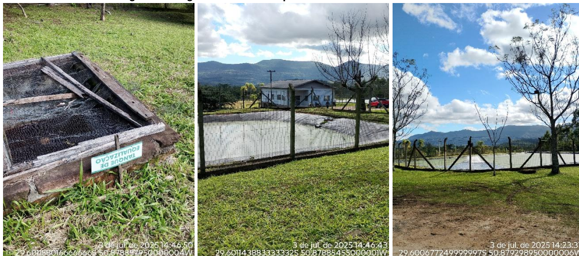
Figura 11: Lagoas utilizadas no processo de tratamento do lixiviado
