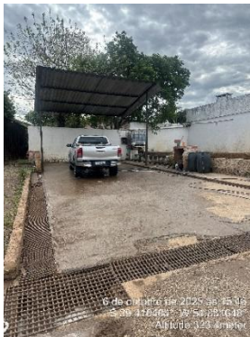
Figura 2: Local de higienização dos contentores
