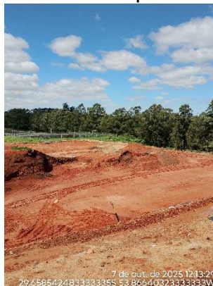
Figura 3: Área em obra para nova célula
