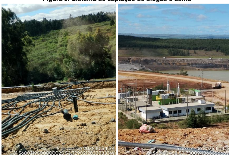
Figura 9: Sistema de captação de biogás e usina
