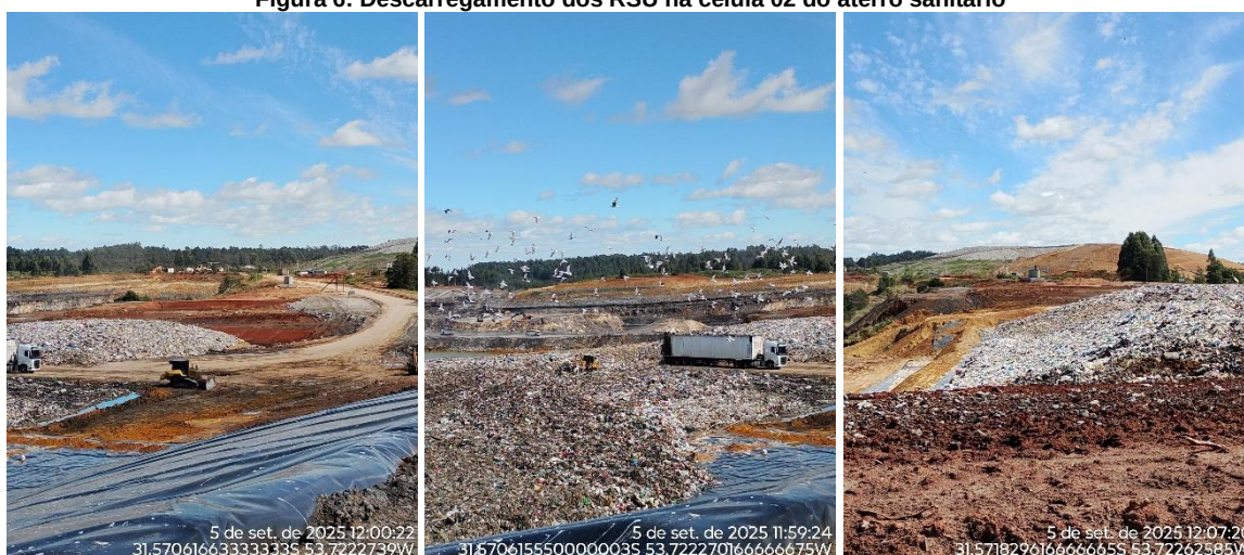
Figura 6: Descarregamento dos RSU na célula 02 do aterro sanitário
