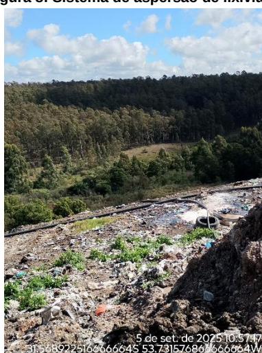
Figura 8: Sistema de aspersão de lixiviado
