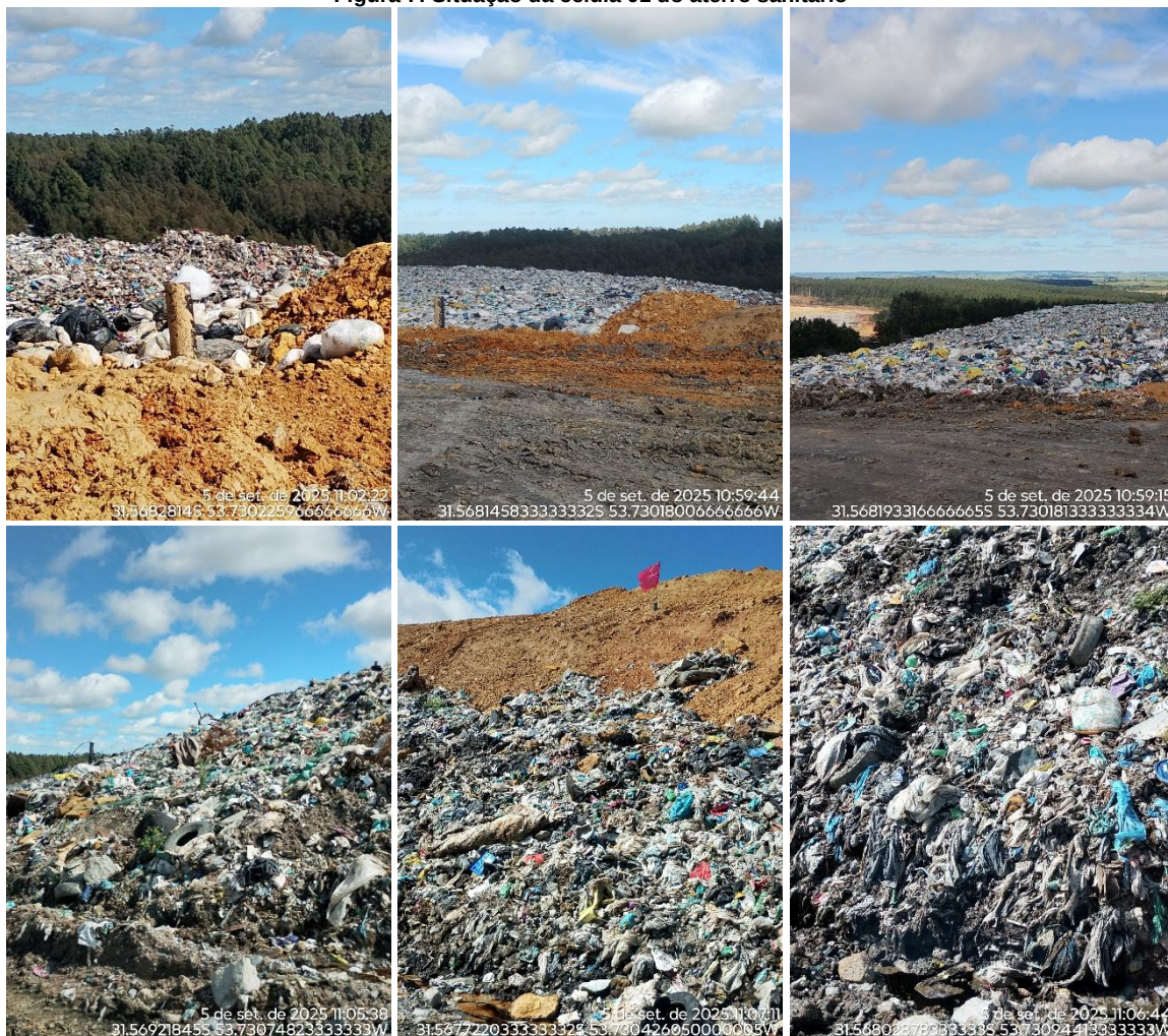
Figura 7: Situação da célula 01 do aterro sanitário
