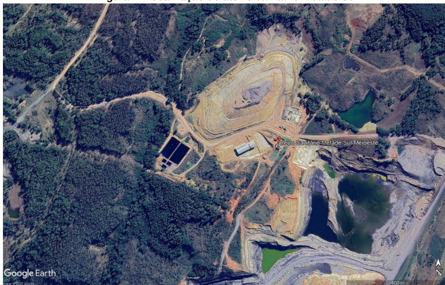
Figura 1: Localização do aterro sanitário Metade Sul
