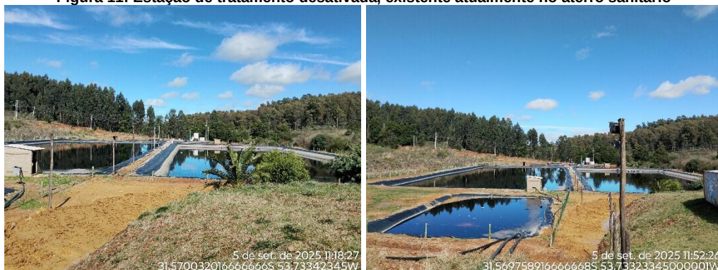
Figura 11: Estação de tratamento desativada, existente atualmente no aterro sanitário
