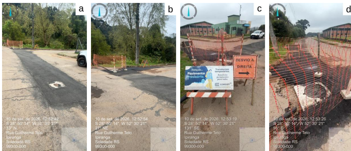
Figura 4. Recomposição provisória e frente de obra na Rua Guilherme Telo, bairro Farroupilha.
