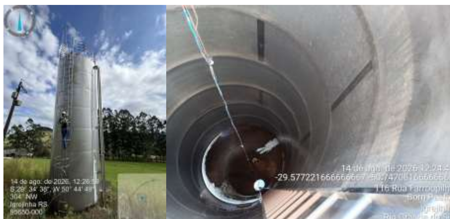
Figura 5: Reservatório R5, em vista externa (à esquerda) e vista interna, sem volume armazenado (à direita), em 14 de agosto de 2026
