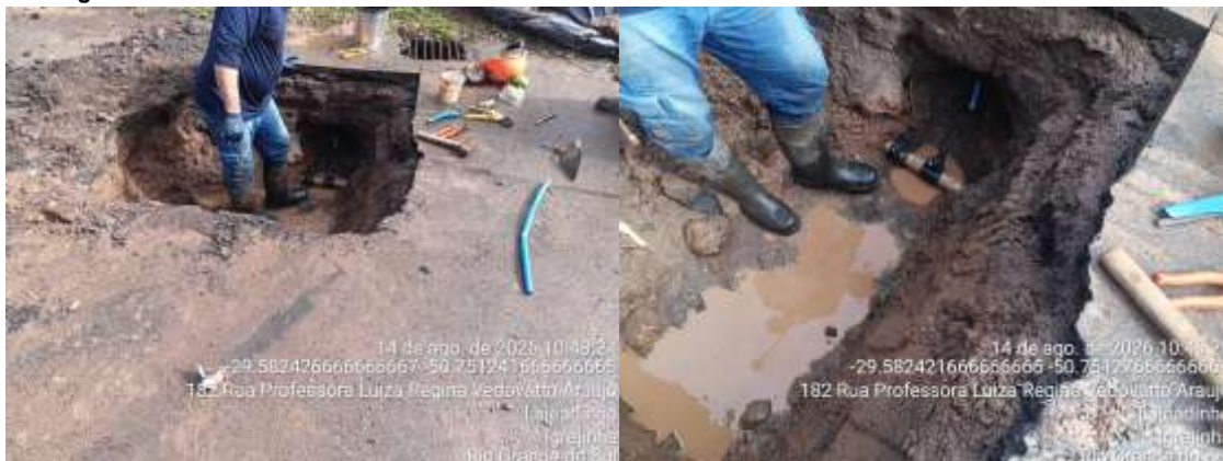
Figura 6: execução do reparo do vazamento em via pública, na Rua Professora Luiza Regina Vedovatto Araujo, n. 182, em 14 de agosto de 2026
