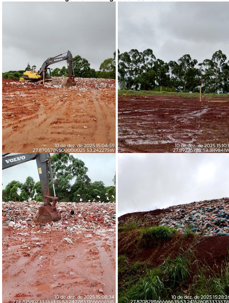
Figura 5: Descarga dos RSU na célula
