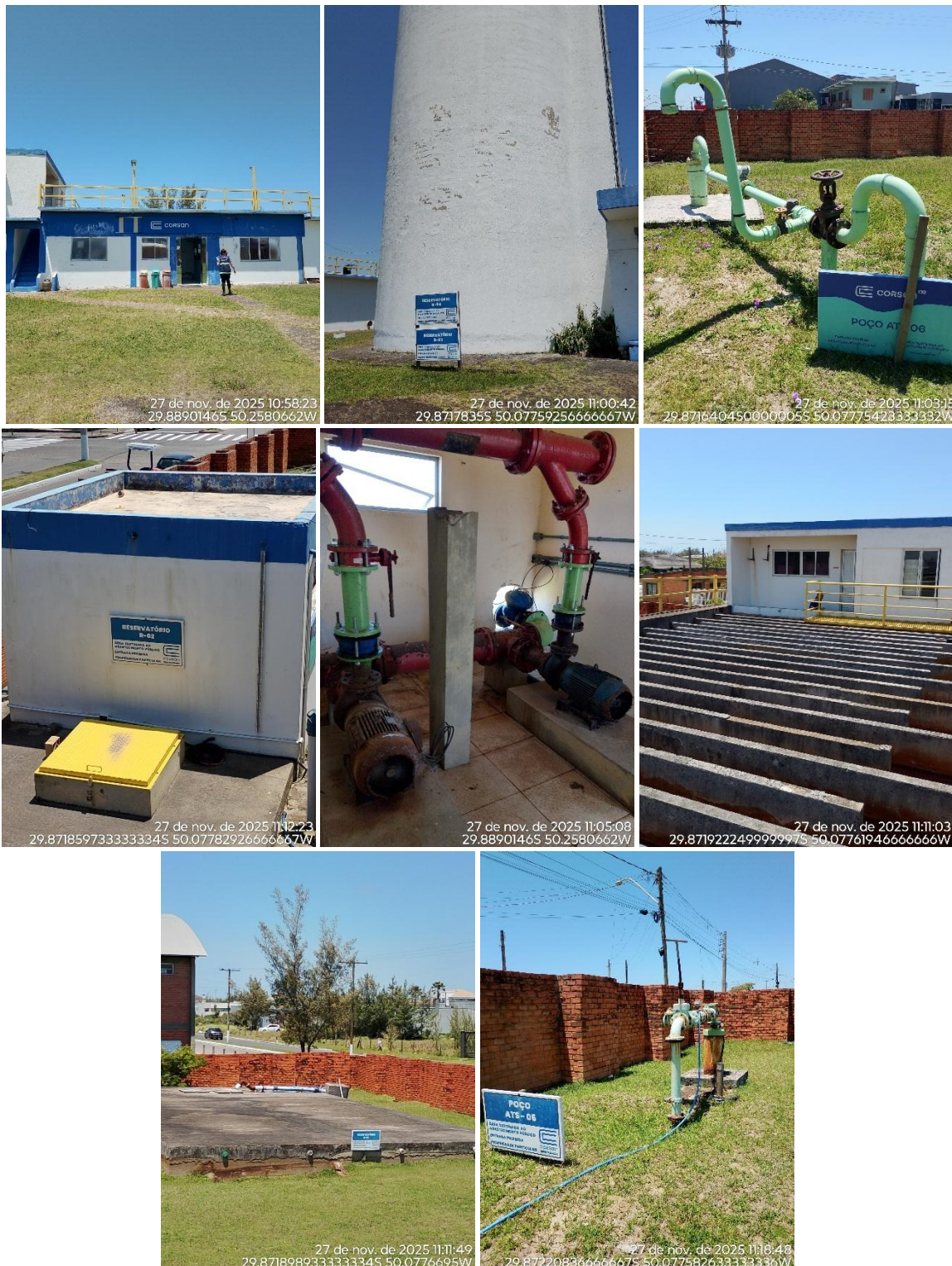
Figura 05: Ativos localizados na unidade do SAA/SES da rua Av. Leme, n. 613 .
