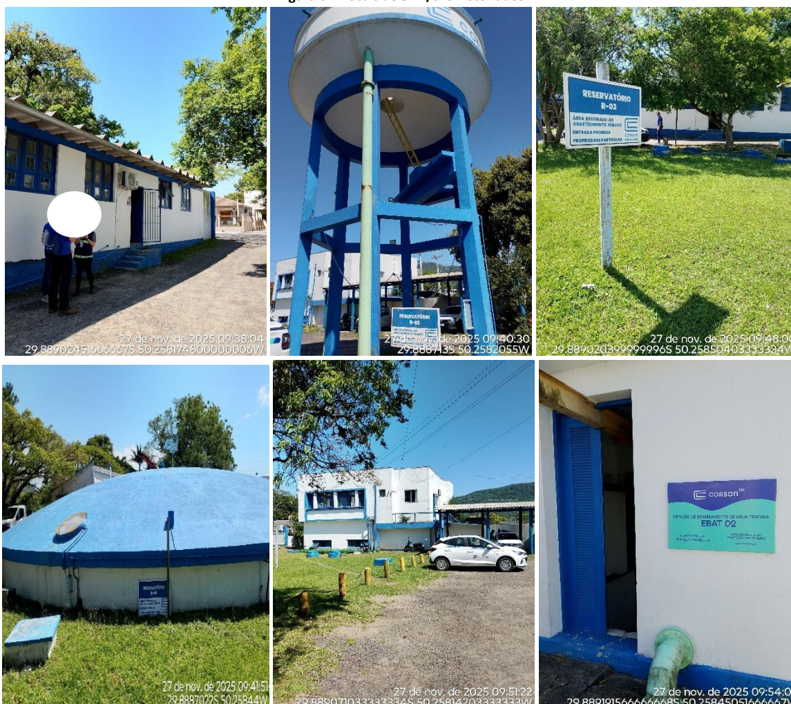
Figura 04: Locais do SAA/SES vistoriados
