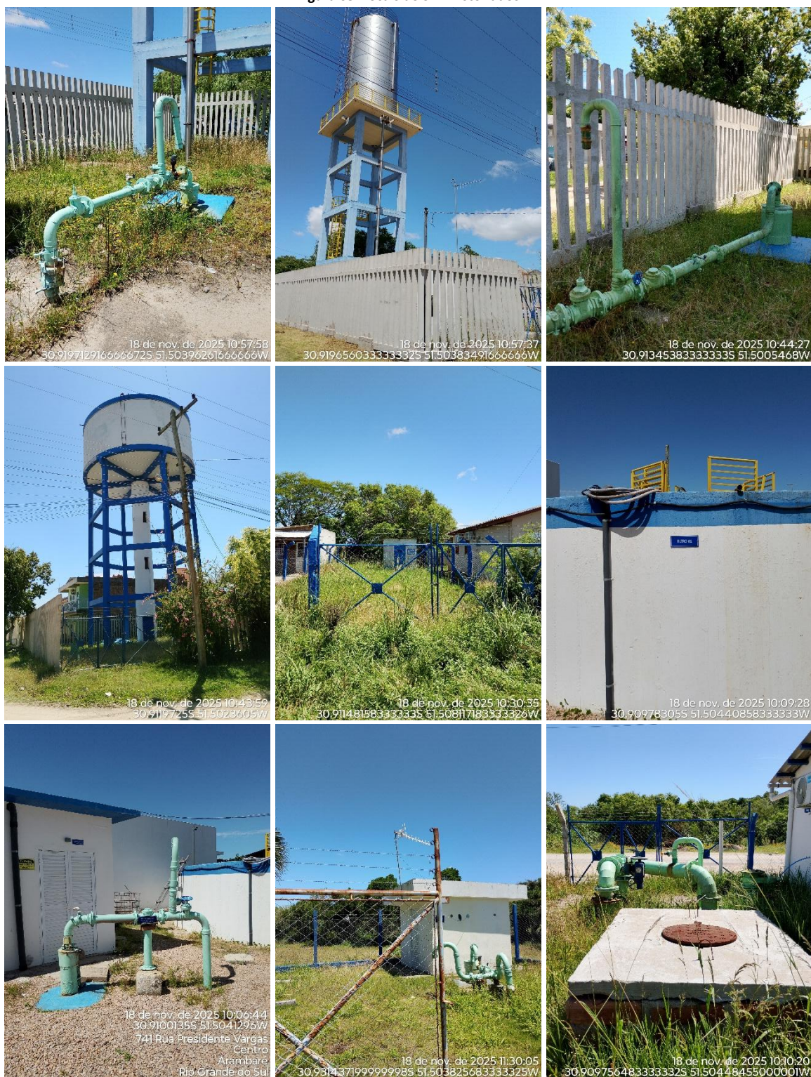
Figura 05: Locais do SAA vistoriados
