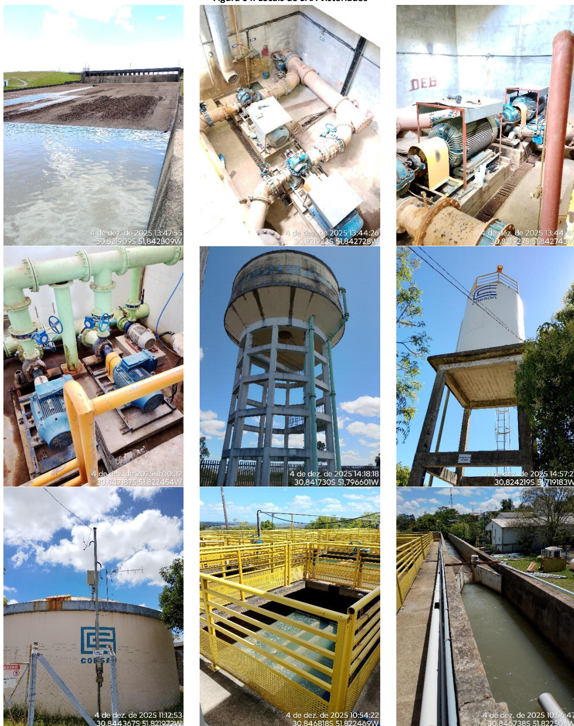
Figura 04: Locais do SAA vistoriados
