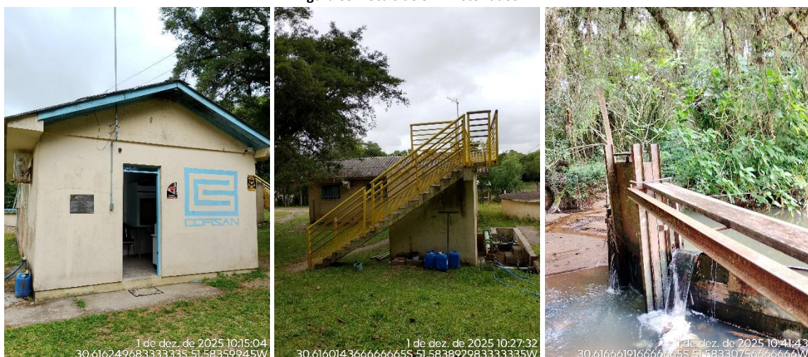
Figura 05: Locais do SAA vistoriados
