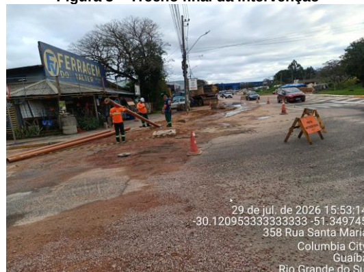
Figura 3 – Trecho final da intervenção
