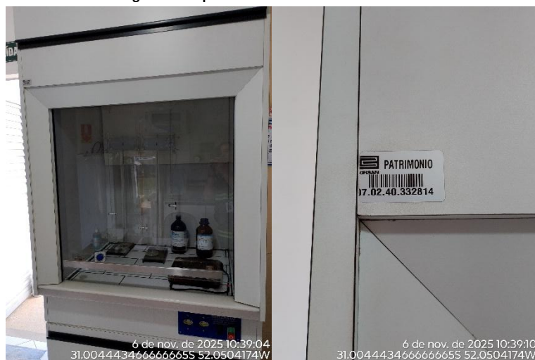
Figura 02: Capela de Exaustão – Laboratório ETA
