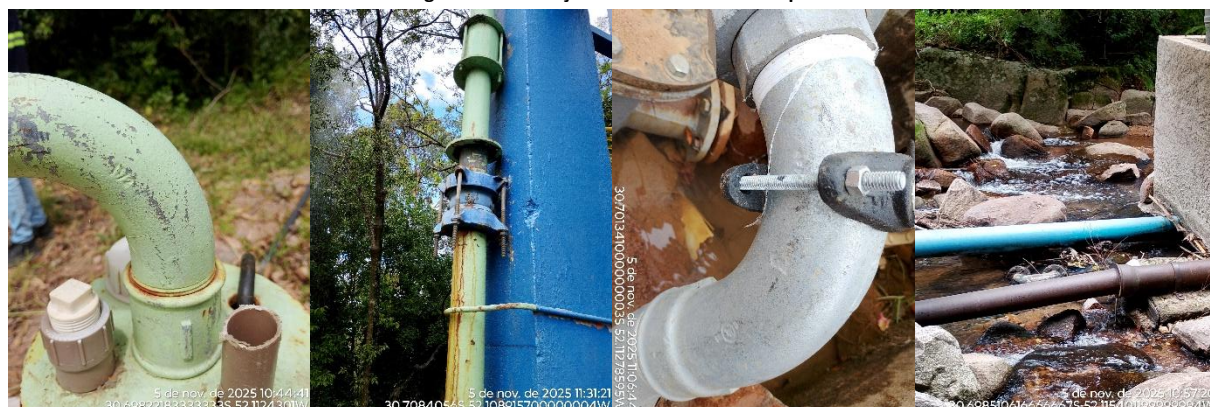
Figura 11: Tubulações instaladas no município
