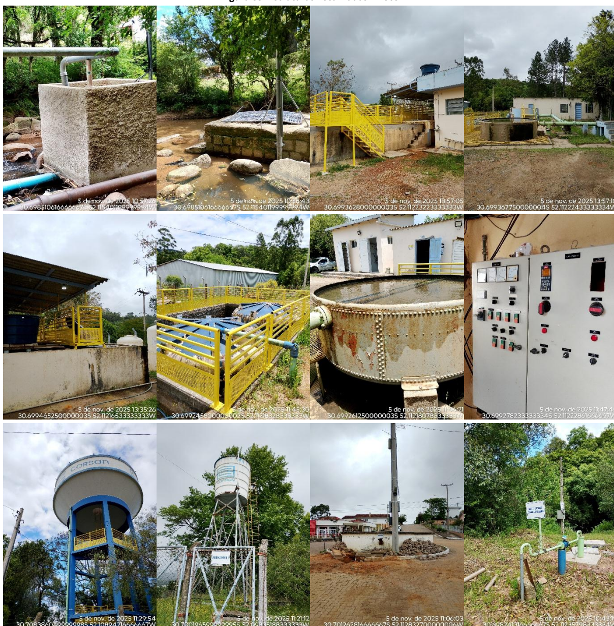
Figura 09: Estruturas fiscalizadas in loco
