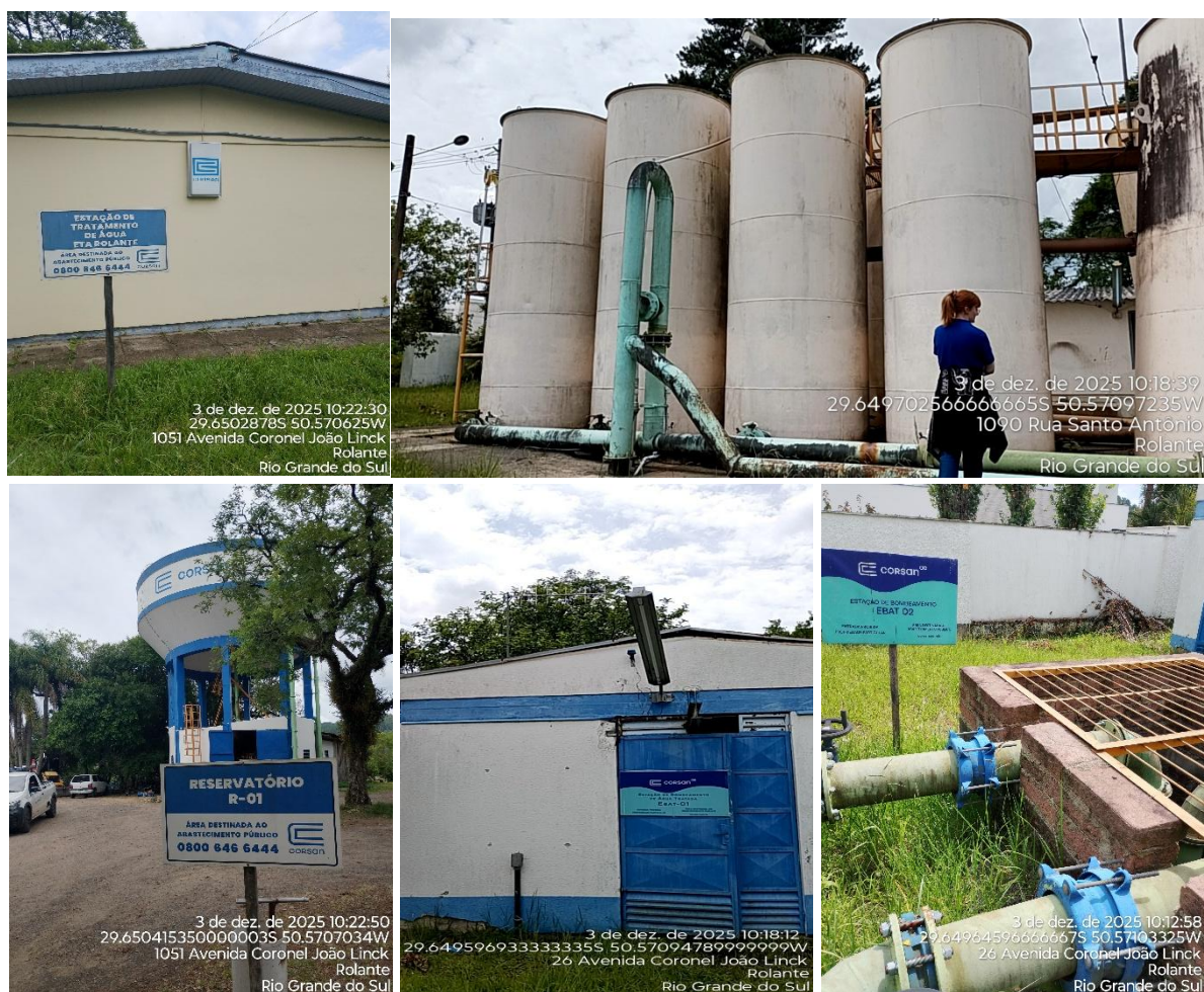
Figura 04: Locais do SAA vistoriados
