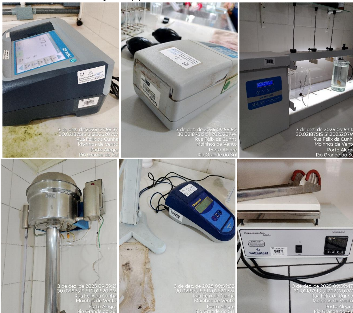
Figura 01: Equipamentos de laboratório existentes na ETA
