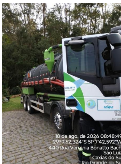
Figura 03: Identificação do processo de caminhão limpa fossa na SLTE Fontana Di Trevi.
