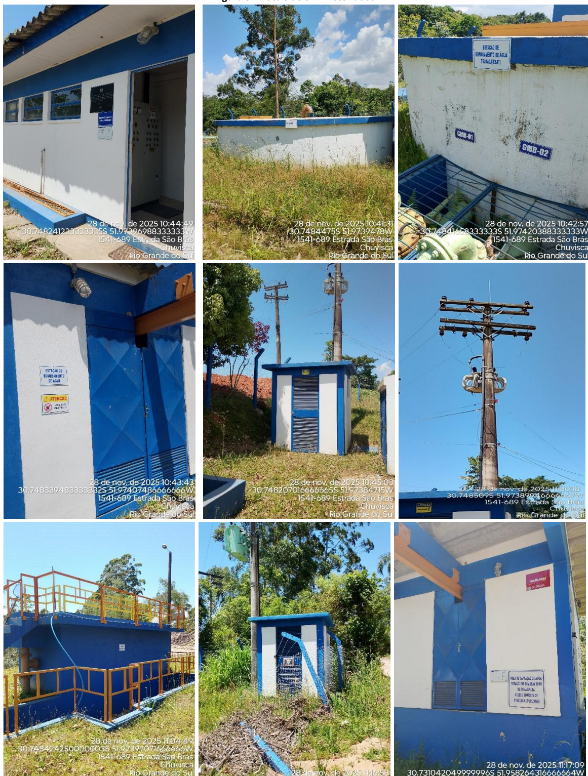
Figura 04: Locais do SAA vistoriados
