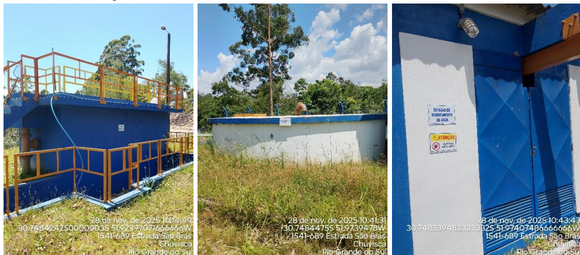
Figura 05: Ativos localizados na unidade do SAA da Estrada São Brás Picada, n.11025.
