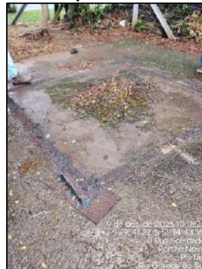
Figura 24: Local onde estava instalado o Reservatório do Hospital.
