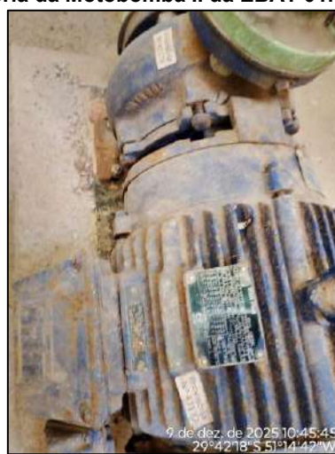
Figura 14: Detalhe da etiqueta de identificação provisória da Motobomba II da EBAT 01.
