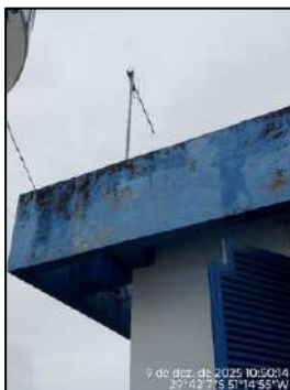
Figura 21: Equipamento de telemetria na EBAT 01.
