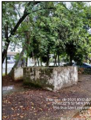
Figura 23: Local onde estava instalado o Reservatório do Hospital.
