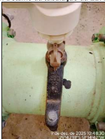
Figura 21: Equipamento de telemetria na EBAT 01.
