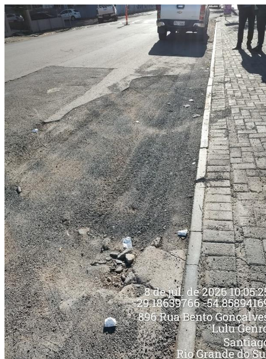
Figura 5 – Registros fotográficos do Ponto 2 da Rua Bento Gonçalves. Erosão e desgaste da via por má pavimentação.
