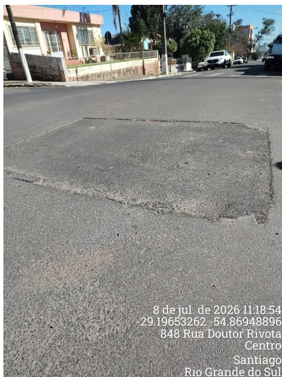
Figura 17 – Registros fotográficos do Ponto 8 na rua Dr. Rivota . Deformação na pavimentação após recorte e reposição de asfalto.
