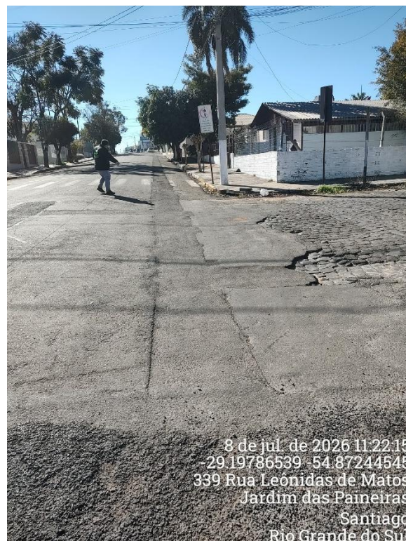
Figura 15 – Registros fotográficos do Ponto 7 nas ruas Pinheiro Machado e Leônidas de Matos. Deformação na pavimentação após recorte e reposição de asfalto.
