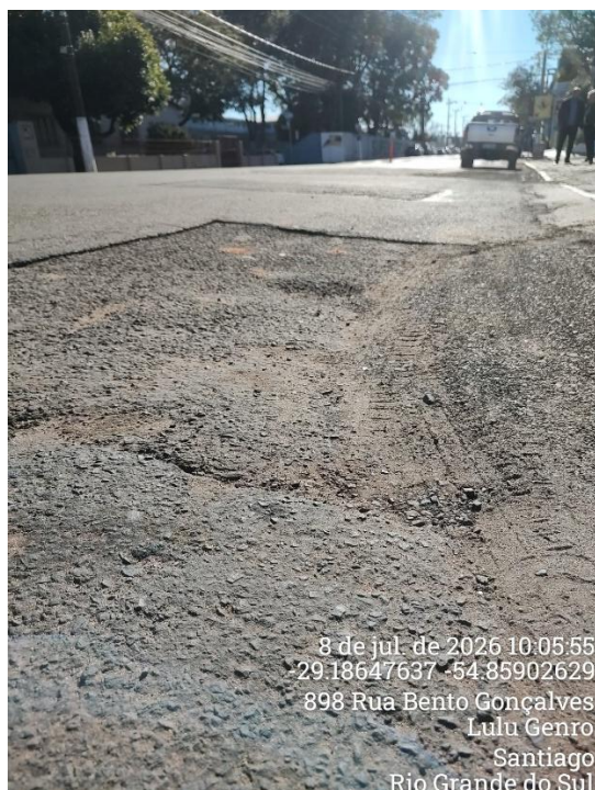
Figura 5 – Registros fotográficos do Ponto 2 da Rua Bento Gonçalves. Erosão e desgaste da via por má pavimentação.
