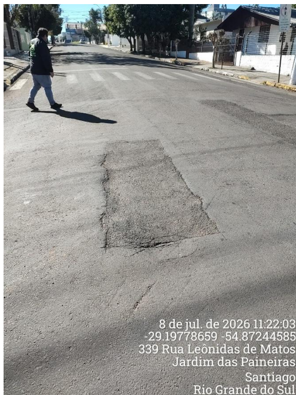
Figura 15 – Registros fotográficos do Ponto 7 nas ruas Pinheiro Machado e Leônidas de Matos. Deformação na pavimentação após recorte e reposição de asfalto.
