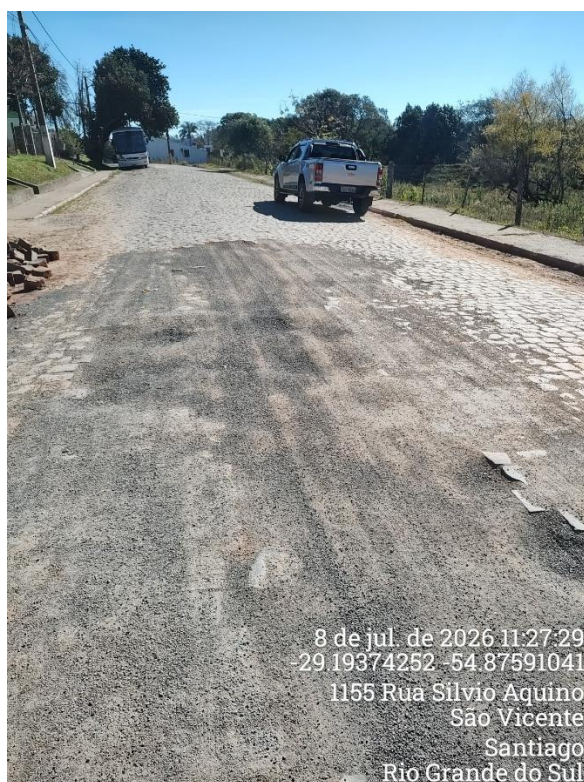
Figura 13 – Registros fotográficos do Ponto 6 da Rua Silvio Aquino. Deformação na pavimentação após retirada do pavimento e recomposição inadequada. Destaca-se material depositado próximo ao meio fio e falta de sinalização.
