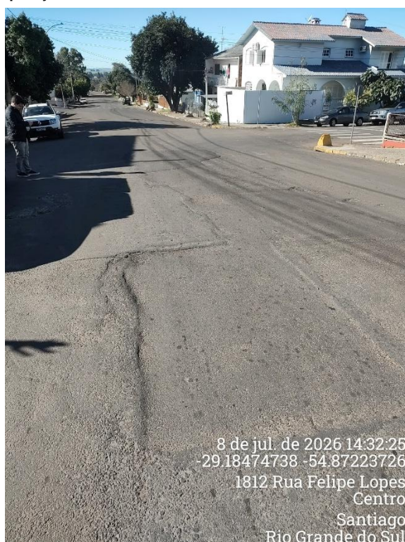
Figura 7 – Registros fotográficos do Ponto 3 da Rua Felipe Lopes. Deformação na pavimentação após recorte e reposição de asfalto.
