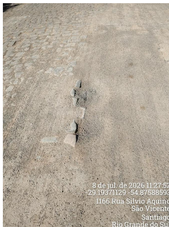
Figura 13 – Registros fotográficos do Ponto 6 da Rua Silvio Aquino. Deformação na pavimentação após retirada do pavimento e recomposição inadequada. Destaca-se material depositado próximo ao meio fio e falta de sinalização.
