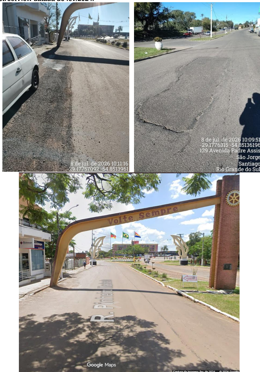
Figura 3 – Registros fotográficos do Ponto 1 da Rua Pinheiro Machado. Erosão e desgaste da via por má pavimentação e comparação com imagem do Google StreetView datada de fev/2024.
