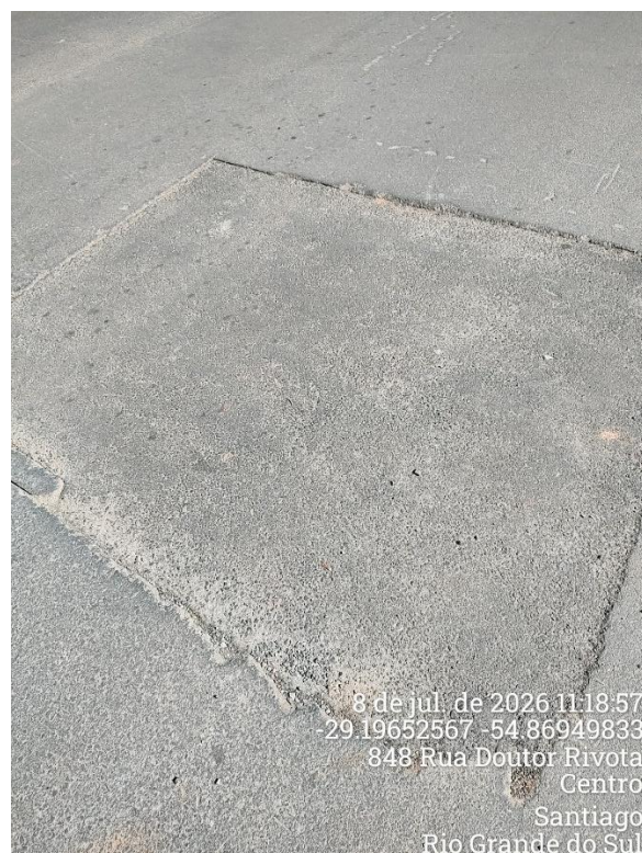
Figura 17 – Registros fotográficos do Ponto 8 na rua Dr. Rivota . Deformação na pavimentação após recorte e reposição de asfalto.
