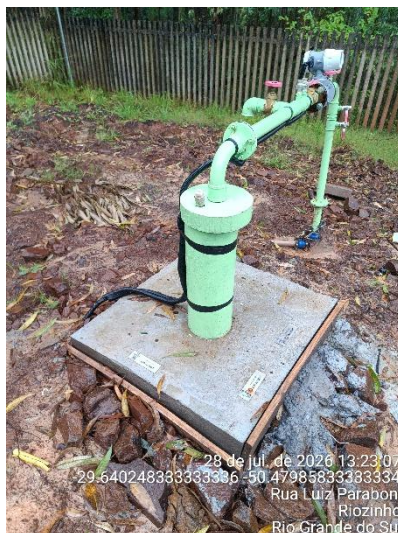
Figura 1 - Novo poço em construção (09)
