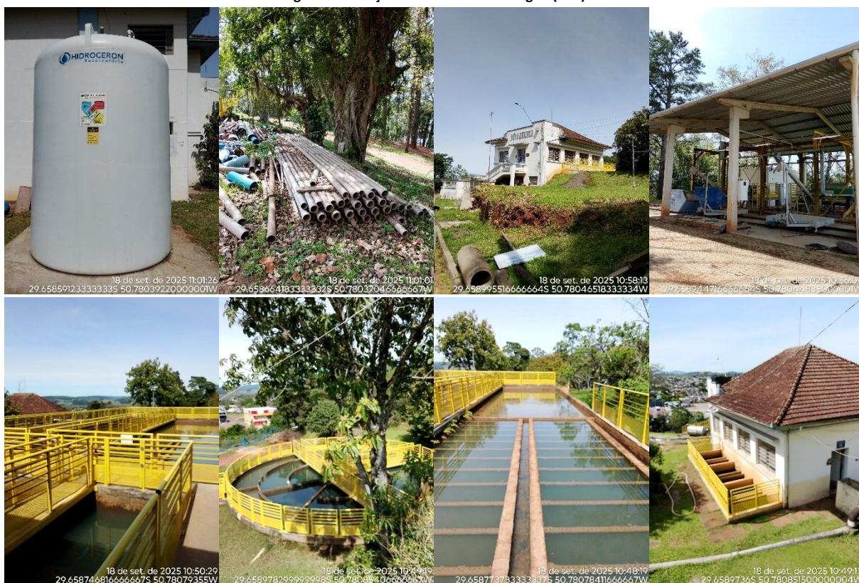
Figura 02: Estação de Tratamento de Água (ETA)
