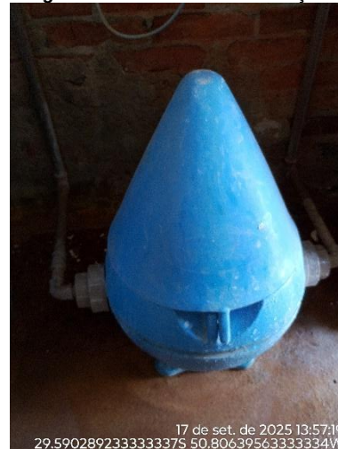
Figura 19: Sistema de fluoretação
