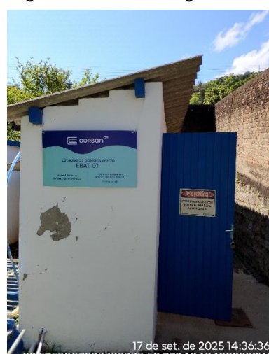
Figura 9: Elevatória de água tratada
