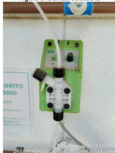
Figura 3: Bomba dosadora
