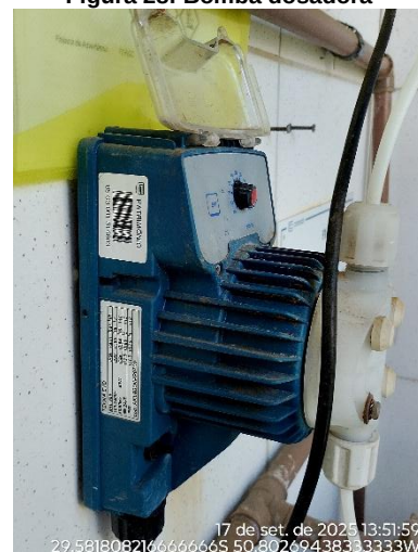
Figura 28: Bomba dosadora
