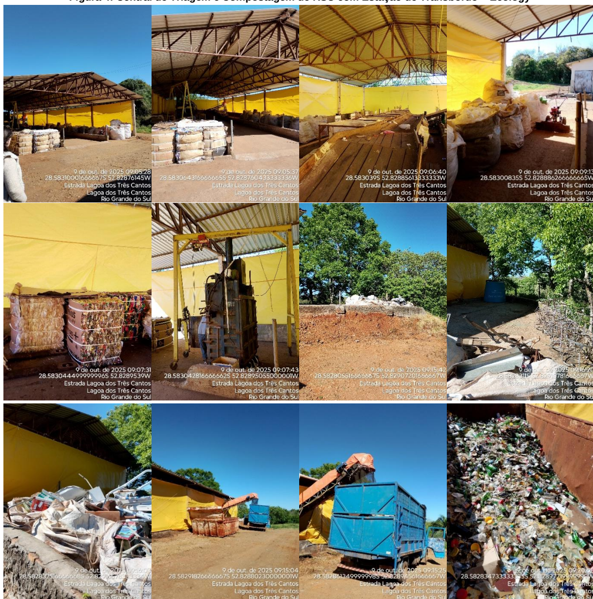
Figura 4: Central de Triagem e Compostagem de RSU com Estação de Transbordo – Ecology
