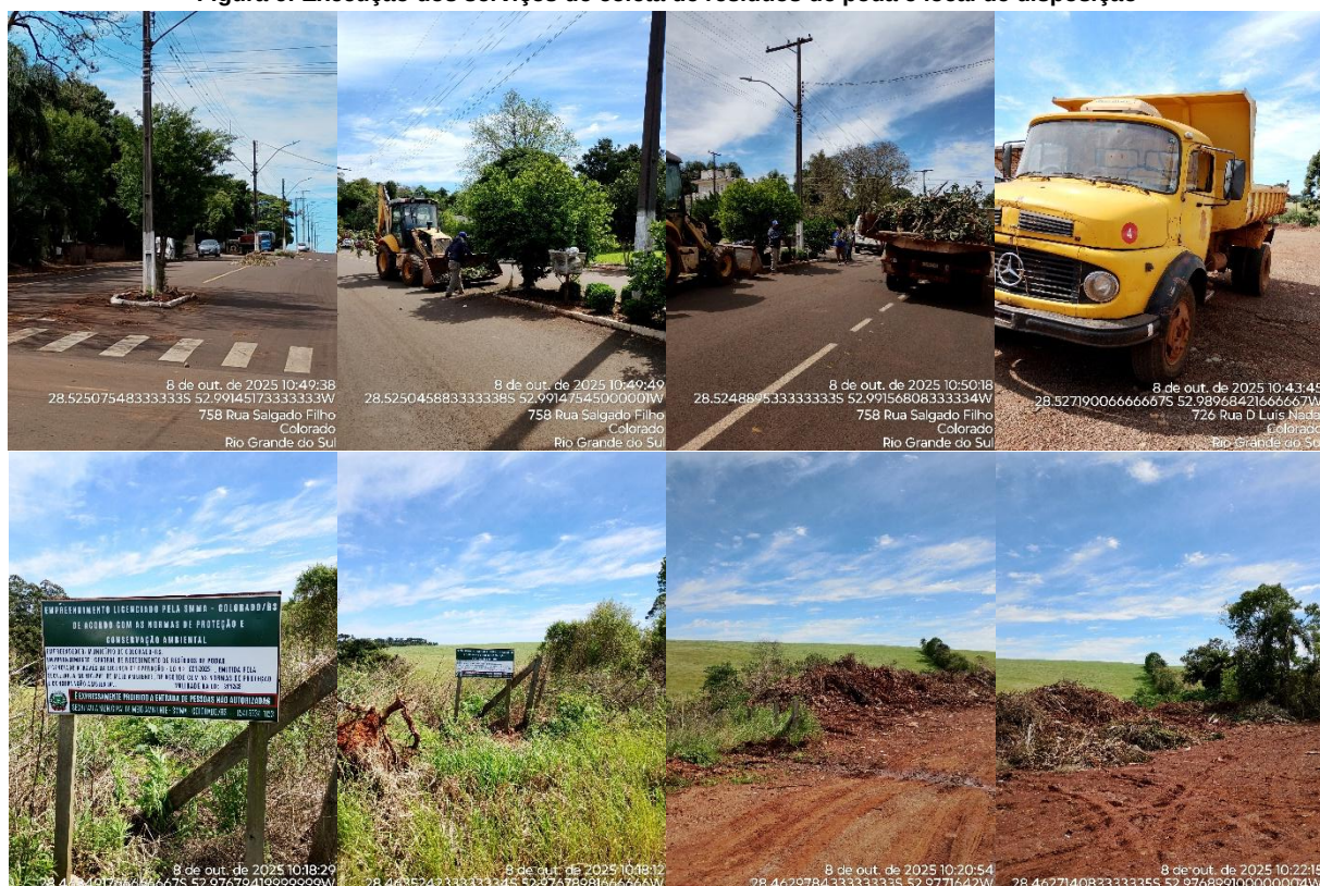
Figura 6: Execução dos serviços de coleta de resíduos de poda e local de disposição
