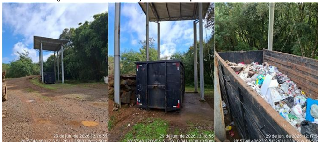
Figura 4: Transbordo dos rejeitos do município de Nova Roma do Sul.
