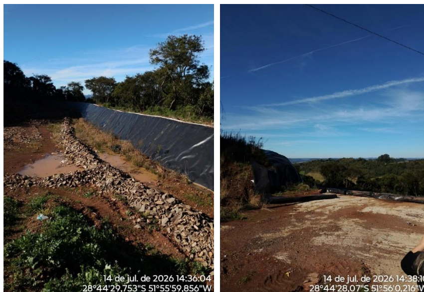
Figura 03: Área em obra de ampliação do aterro sanitário.
