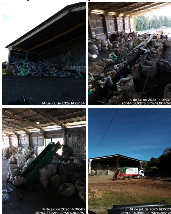
Figura 07: Unidade de triagem existente no aterro sanitário.
