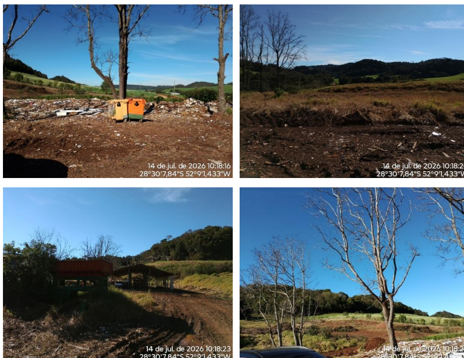
Figura 06: Unidade de disposição de resíduos volumosos
