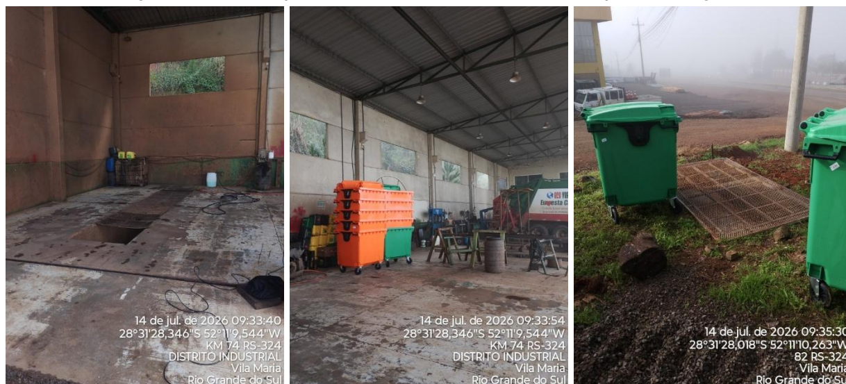
Figura 03: Local de limpeza dos contentores e caminhões e caixa separadora de água e óleo
