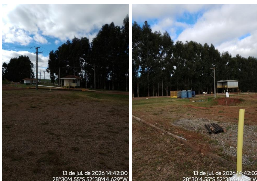
Figura 03: identificação da balança rodoviária e área de desenlonamento.
