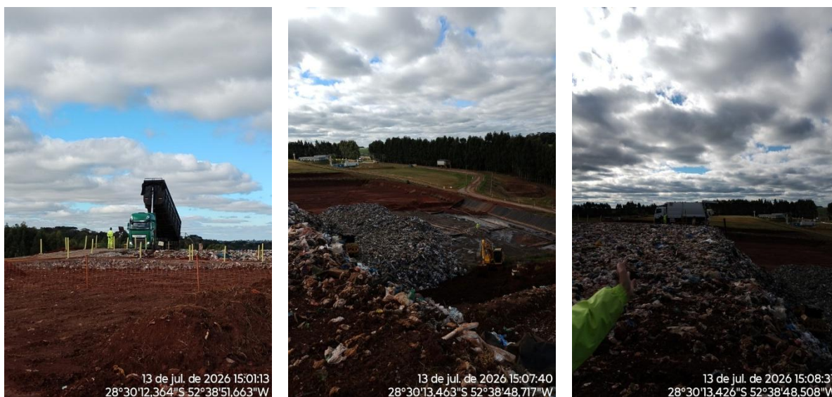
Figura 04: Descarga dos RSU na célula
