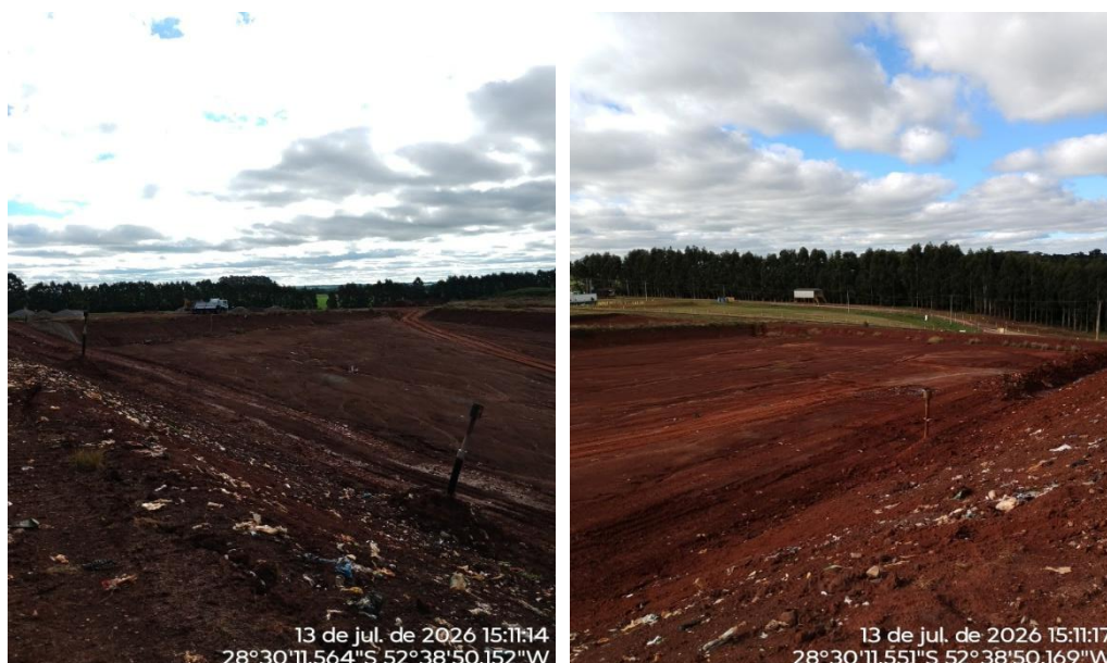
Figura 05: Área de expansão da célula de disposição final de rejeitos.
