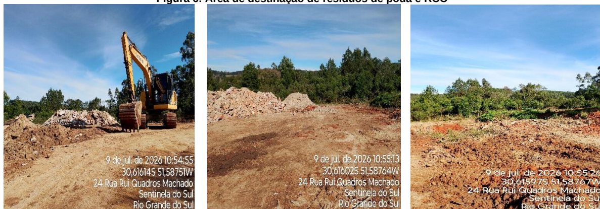
Figura 6: Área de destinação de resíduos de poda e RCC
