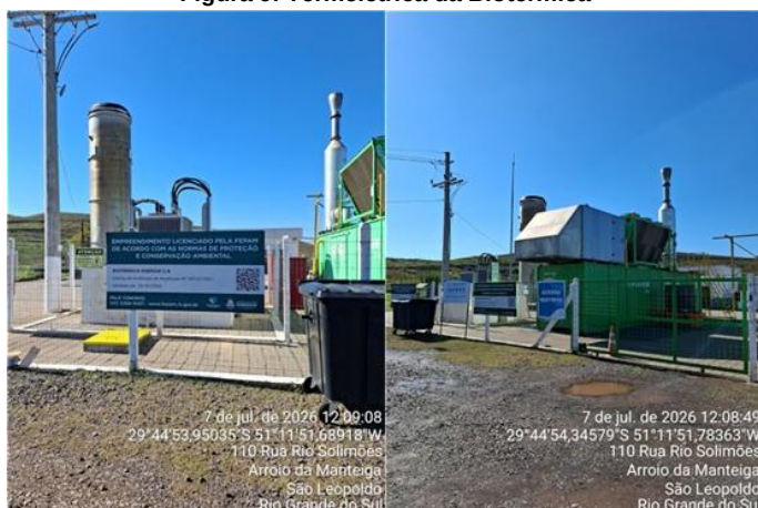
Figura 9: Termelétrica da Biotérmica
