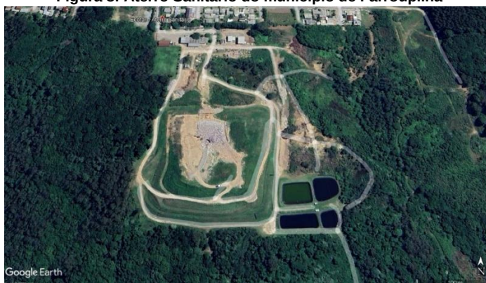
Figura 8: Aterro Sanitário do município de Farroupilha
