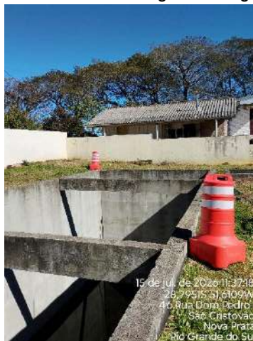
Figura 2 – Sistema de reciclo da água de lavagem dos filtros
