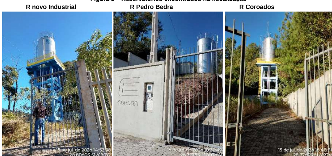
Figura 5 – Reservatórios encontrados na fiscalização
