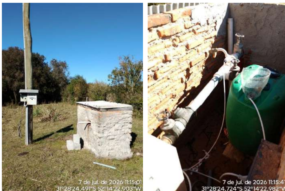
Figura 02: Poço Corrientes em Pelotas/RS.
