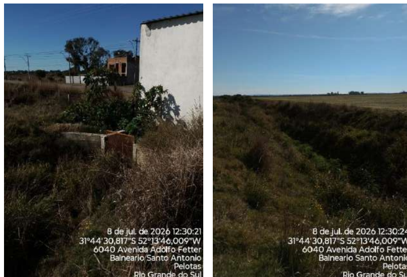
Figura 01: Identificação da estrutura de captação desativada.
