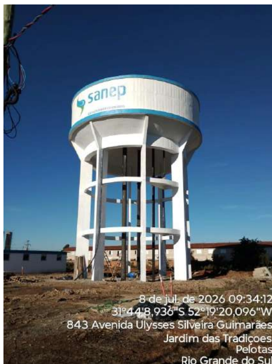
Figura 05: Identificação do reservatório Jardim das Tradições em obras.
