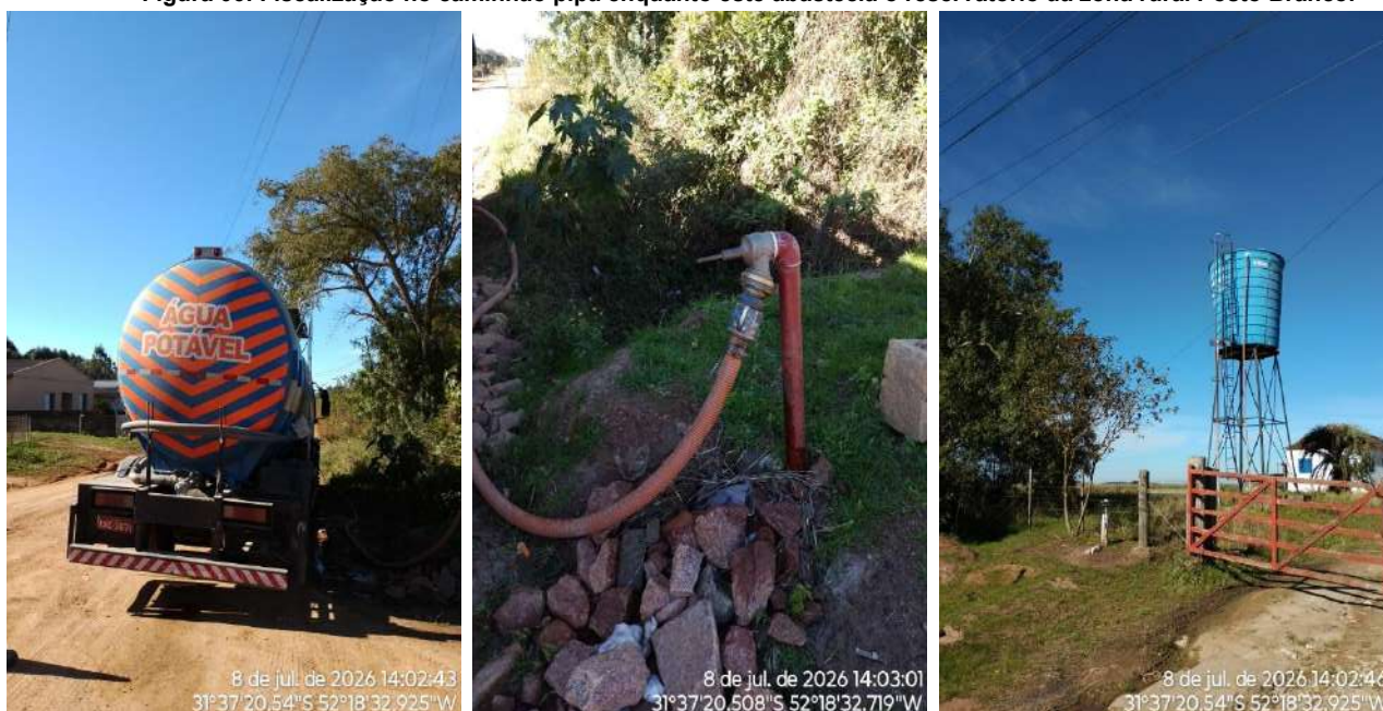
Figura 06: Fiscalização no caminhão pipa enquanto este abastecia o reservatório da zona rural Posto Branco.
