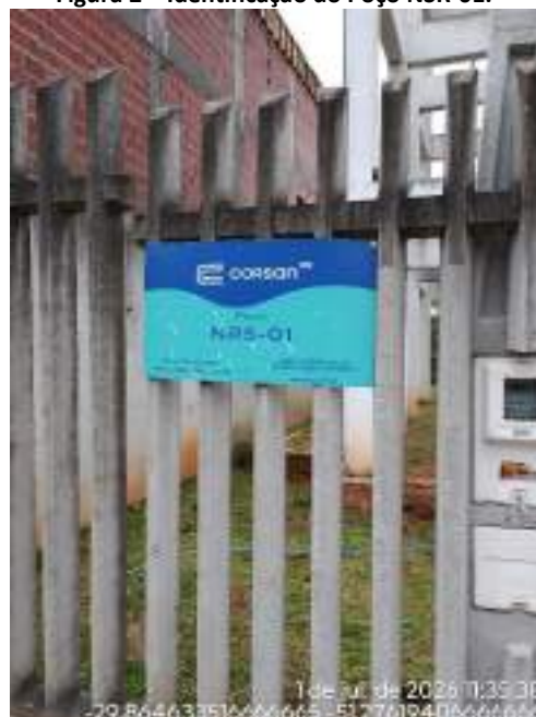
Figura 2 – Identificação do Poço NSR-01.
