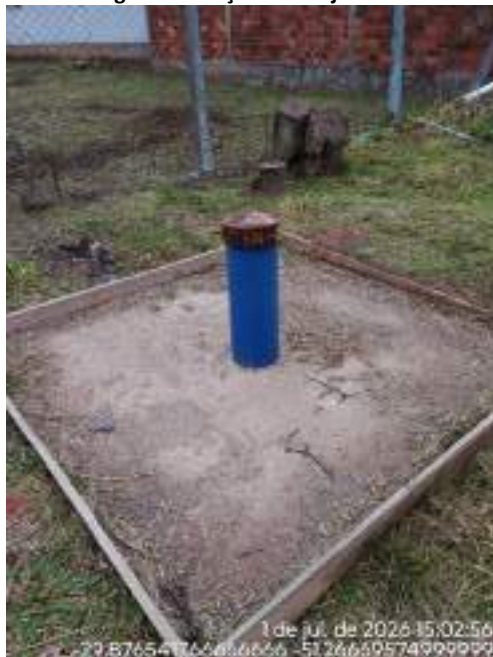
Figura 3 – Poço NSR-02 junto ao R-3.
